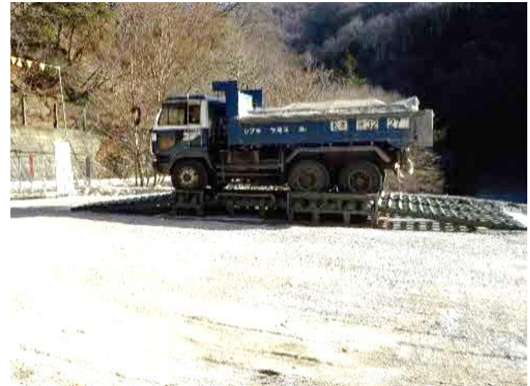
写真② 周辺道路の清掃及び散水、タイヤ洗浄機の設置
