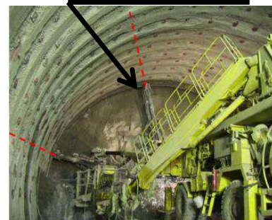
5.ロックボルト打設
