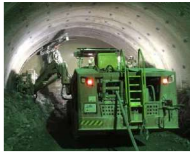
3.鋼製支保工建込
