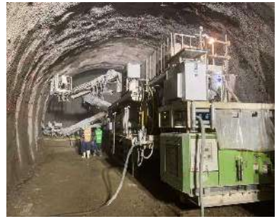
4.吹付けコンクリート
