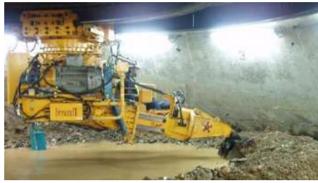
④掘削、沈設
