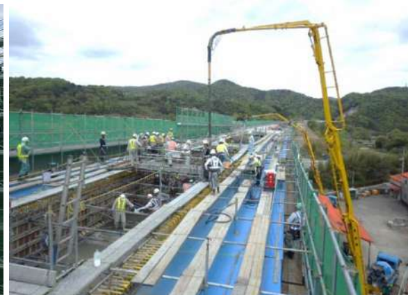
③ 上部工コンクリート打設
