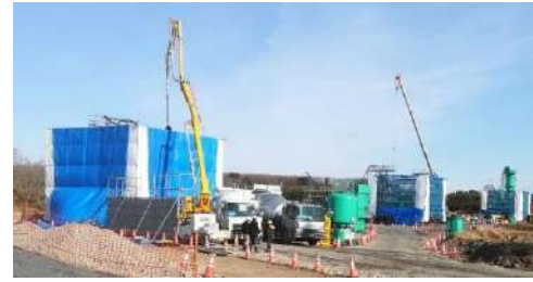
⑥橋脚部コンクリート打設
