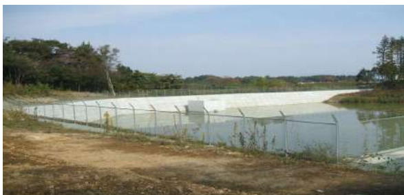
ブロック積掘り込み調整池
