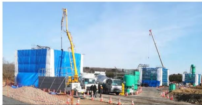
⑥ 橋脚部コンクリート打設
