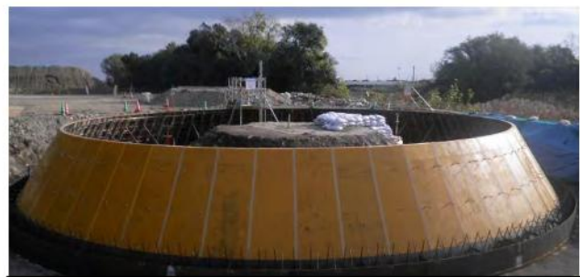
①作業室構築
