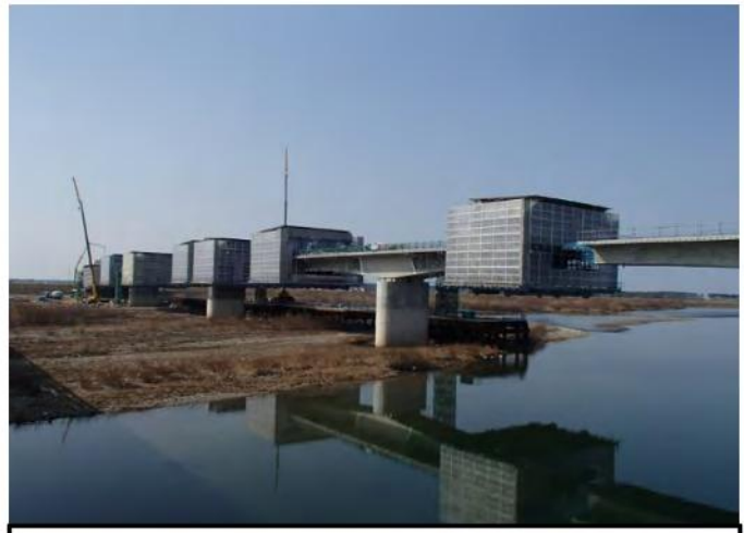
③張出施工
