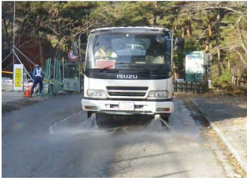
⑧ 道路の清掃・散水状況
