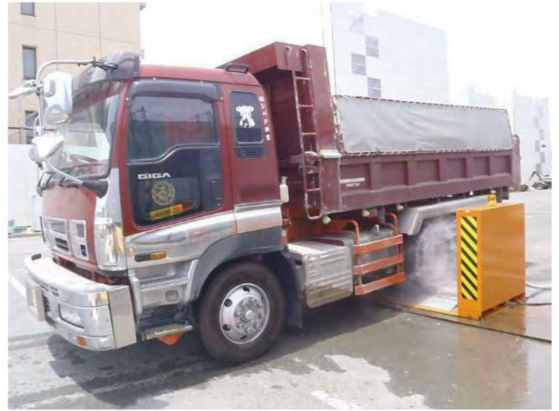
⑨ タイヤの洗浄状況
