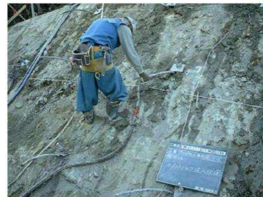
セメントミルク注入
