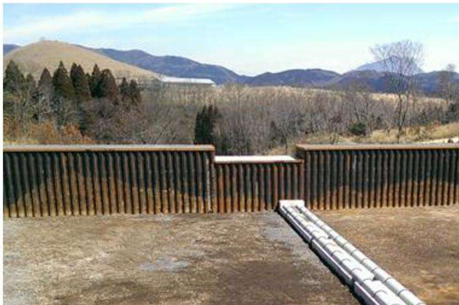
調整池堤体内部の施工例
