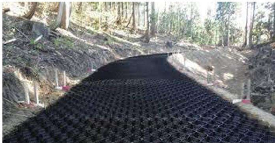
グラウンドセル材の展開状況
