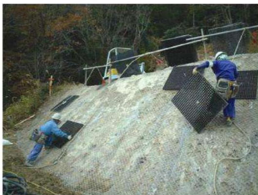
パネル設置（人力施工）
