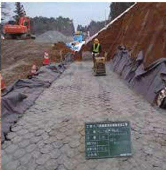
小型機械による転圧状況
