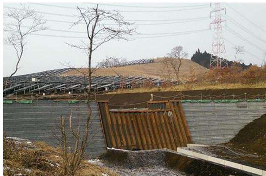
調整池堤体下流部の施工例
