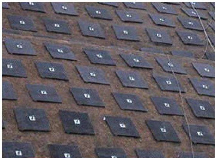
施工完了直後の状況
