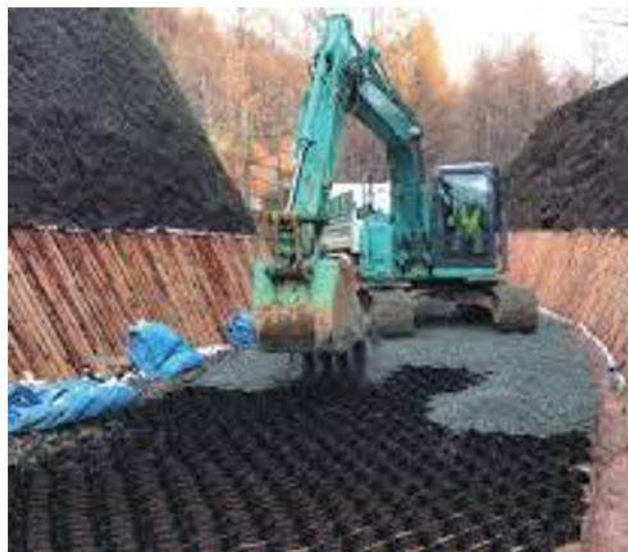
重機による碎石充填状況
