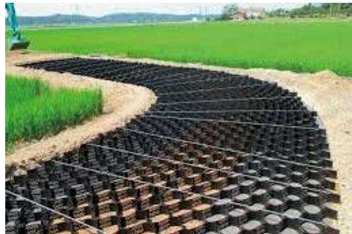
グラウンドセル材のカーブ展開状況
