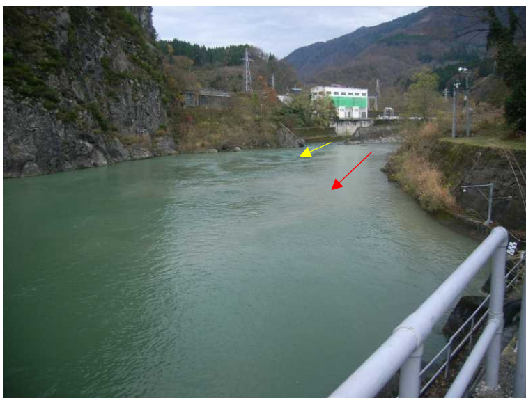
写真-1 姫六堰堤上流 姫川本川に濁りあり（赤矢印）。 上流側発電所放流（黄色矢印）は 比較的濁っていない。
