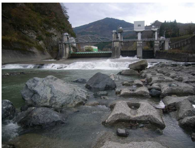
写真-3 姫六堰堤下流 堰堤両岸で放流があり、採水地 点で水が混ざっていない可能性 がある。
