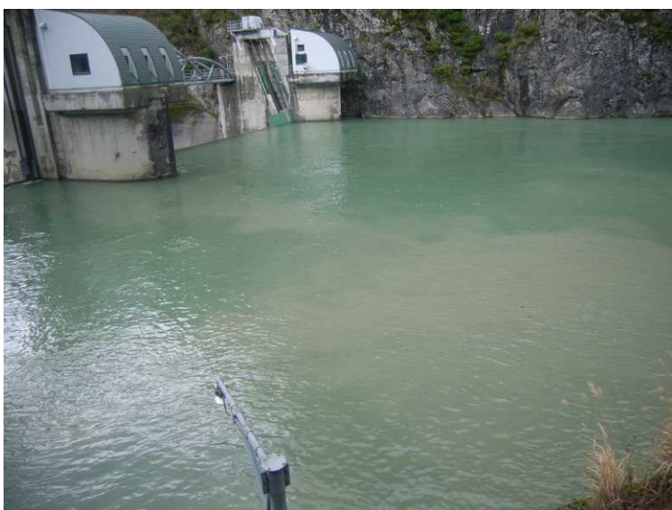
写真-2 姫六堰堤上流 本川の水と上流側発電所放流水が よく混ざらずに流下している。
