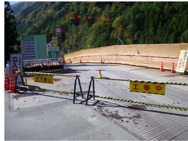
工事現場への立ち入り禁止柵
