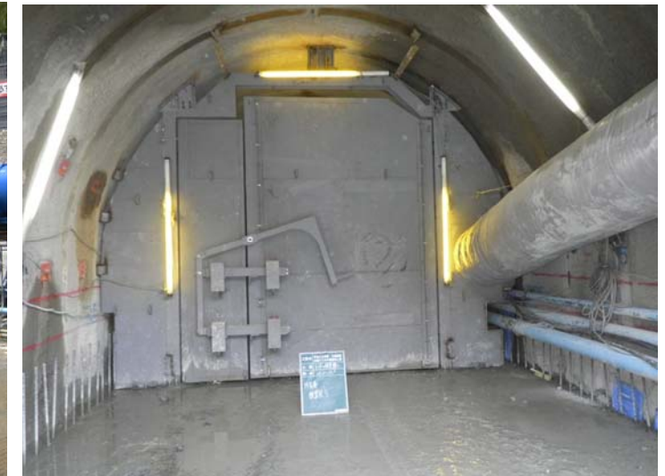
トンネル坑口 防音扉の設置
