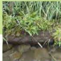
バイオログなどに加工された天然ヤシ繊維は、河川の汚濁防止や水際の植生基盤として利用されます。
