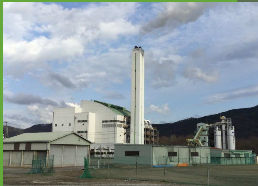
現有施設(焼却プラント) 150t/日(50t/16h×3炉)
