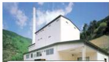
クリーンセンターたつの 平成5年稼働(18年経過) 施設規模:30トン/日 処理対象物:燃やせるごみ
