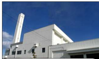
伊那中央清掃センター 昭和63年稼働(23年経過) 施設規模:120トン/日 処理対象物:燃やせるごみ
