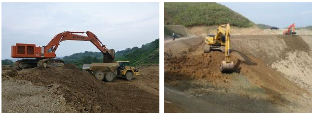
写真 1-6-6 造成工事参考写真
