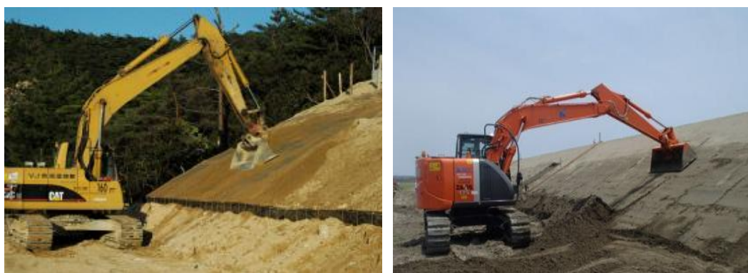
写真 1-6-7 盛土法面整形工事参考写真
