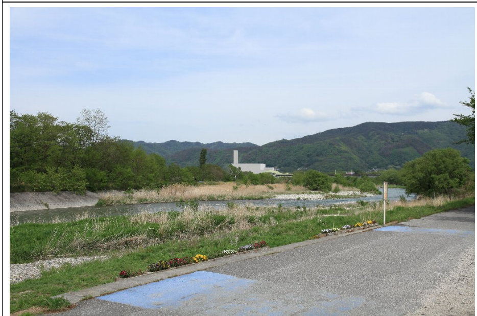
存在・供用時（春季、既存焼却施設解体撤去後）
