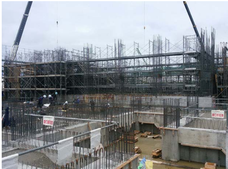
工場棟 基礎・躯体工事
