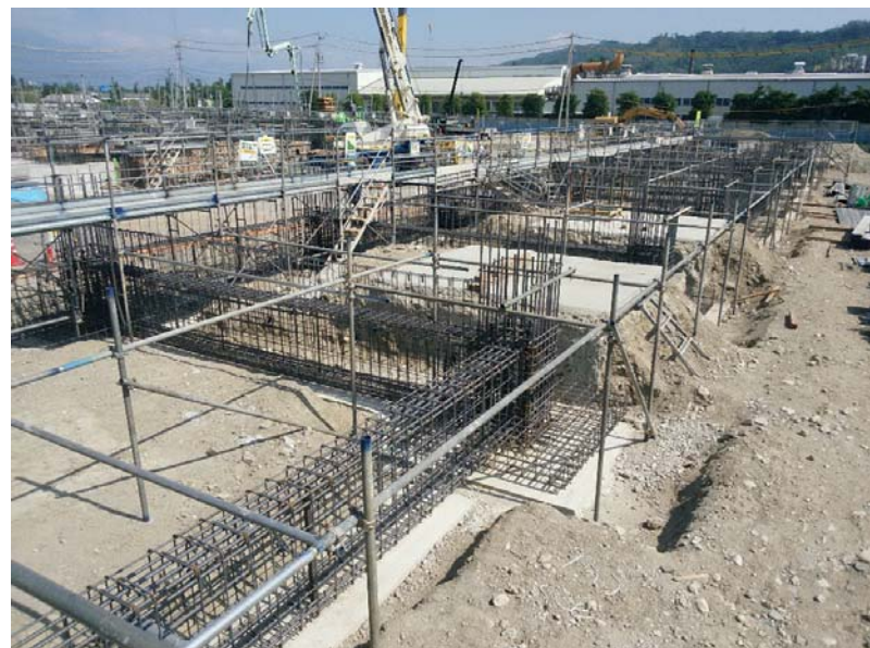
ランプウェイ 基礎工事
