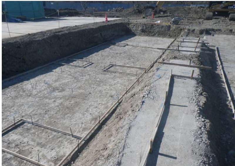
工場棟 地盤改良・土工事
