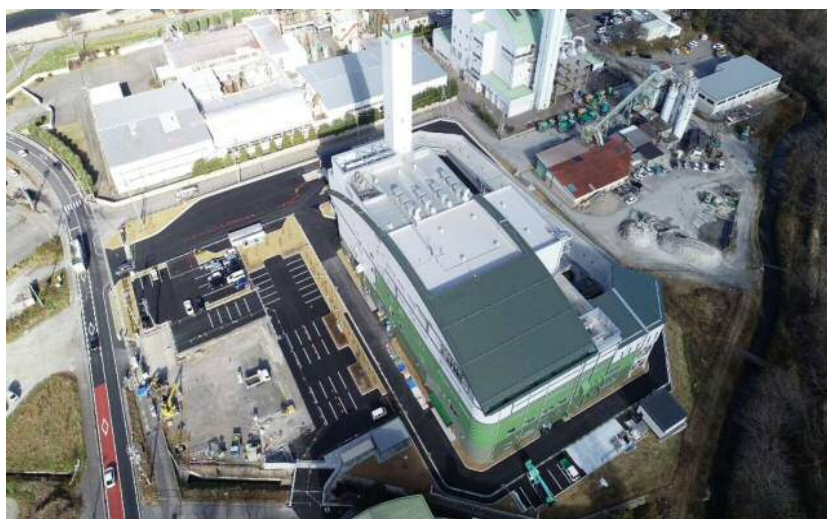
11月 工場棟 建築工事
