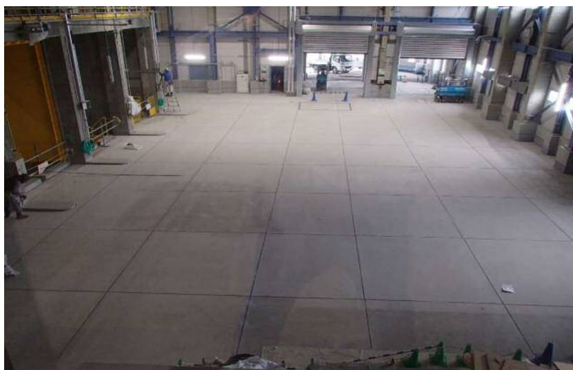
10月 工場棟3階プラットフォーム 建築工事
