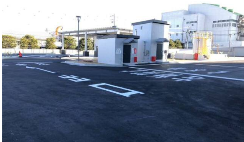
12月 計量棟・油脂庫・助燃油ポンプ室 建築工事
