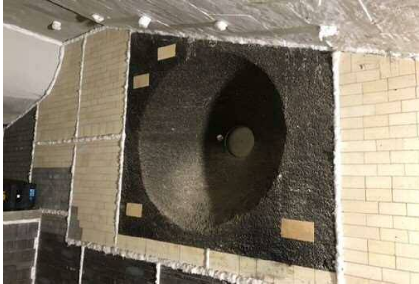
10月 プラント工事 耐火物施工完了
