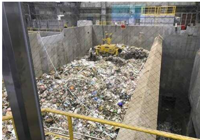
12月 プラント工事 ごみ受入れ状況
