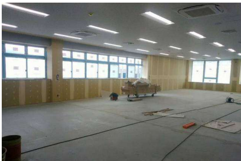
7月 工場棟 建築工事
