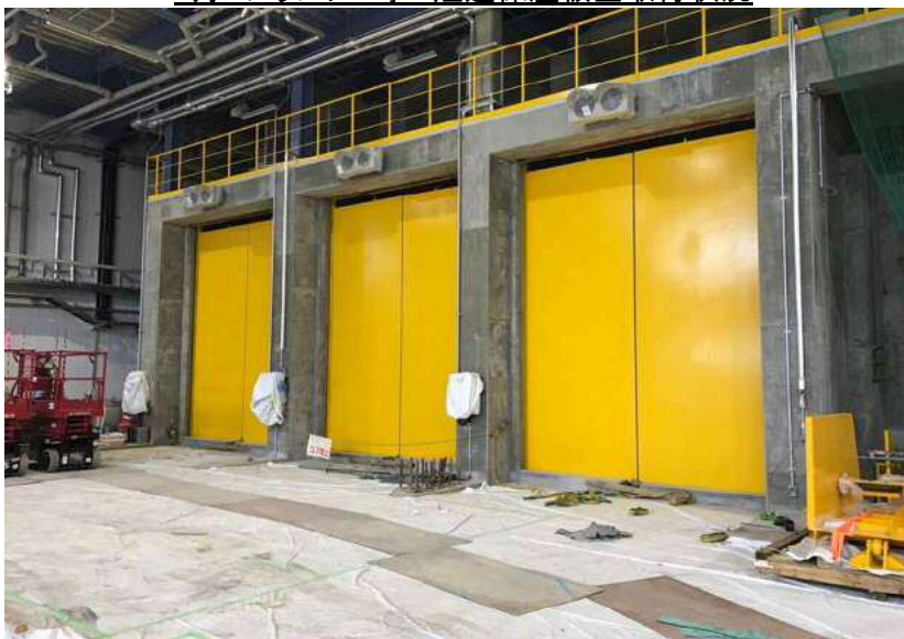
9月 プラント工事 ごみ投入扉据付状況
