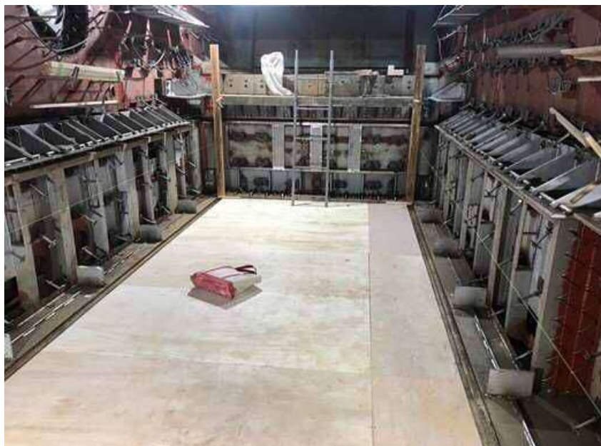
7月 プラント工事 炉内耐火物施工前状況
