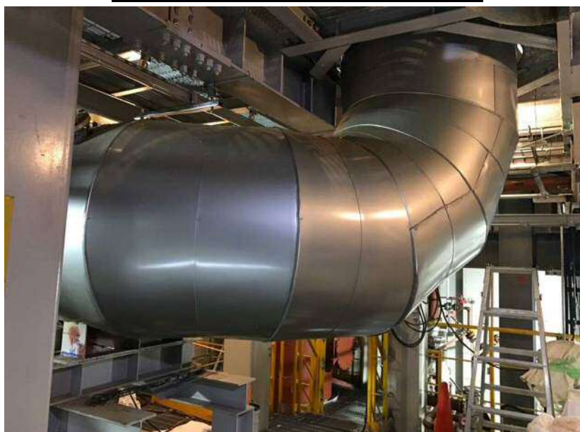
8月 プラント工事 煙道保温板金取付状況
