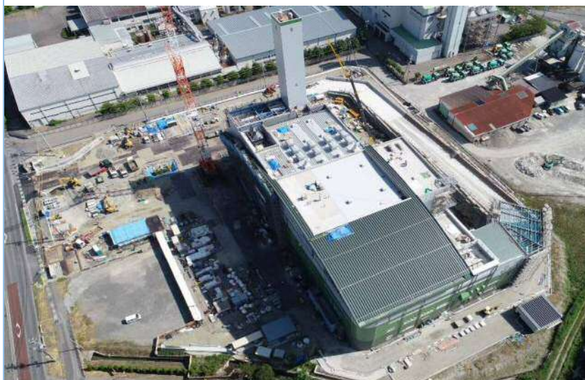
8月 工場棟 建築工事
