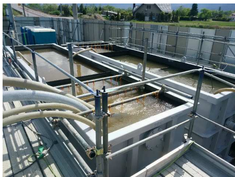
排水処理状況①
