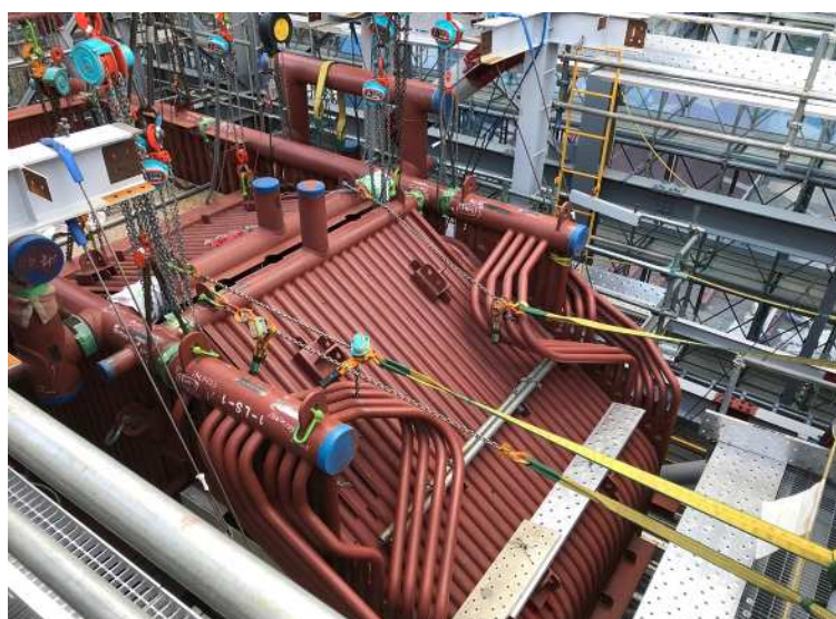
プラント工事 ボイラ据付状況 (5月)
