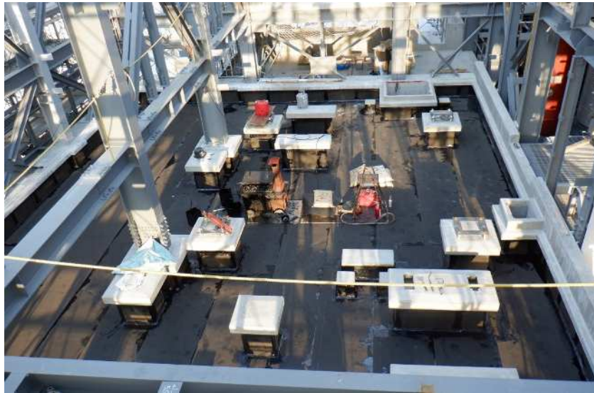
工場棟 建築工事 (4月)
