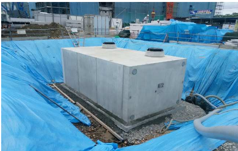
防火水槽 建築工事 (6月)
