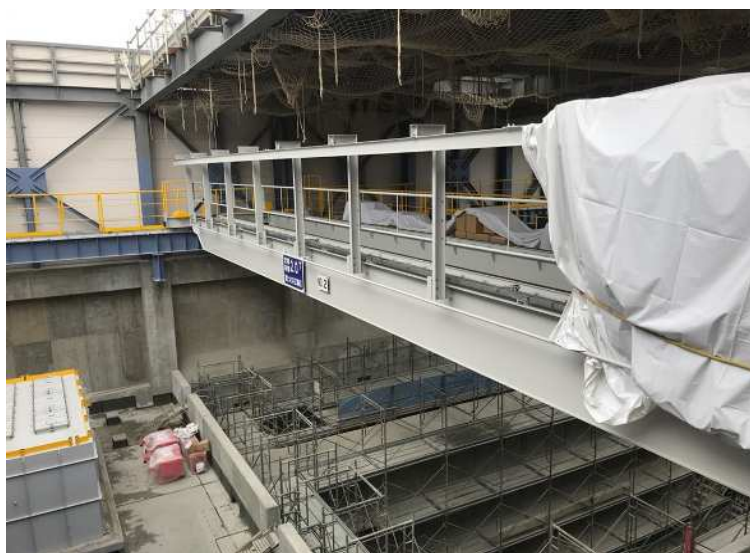
プラント工事 ごみクレーン据付状況 (6月)
