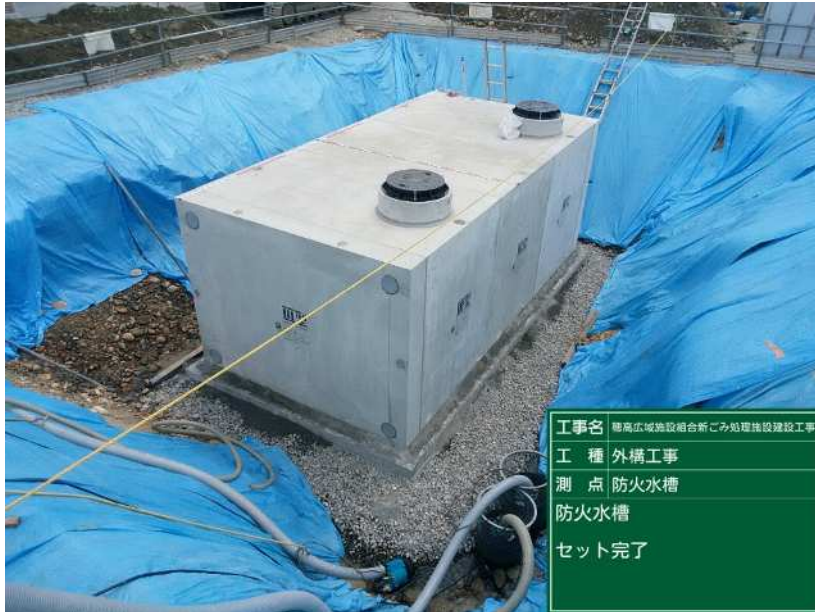
防火水槽 据付完了
