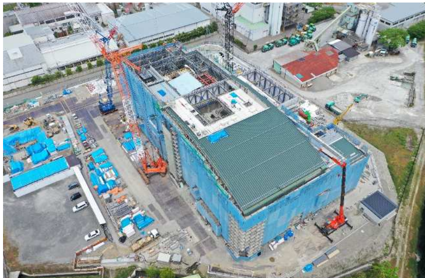
工場棟 建築工事 (5月)
