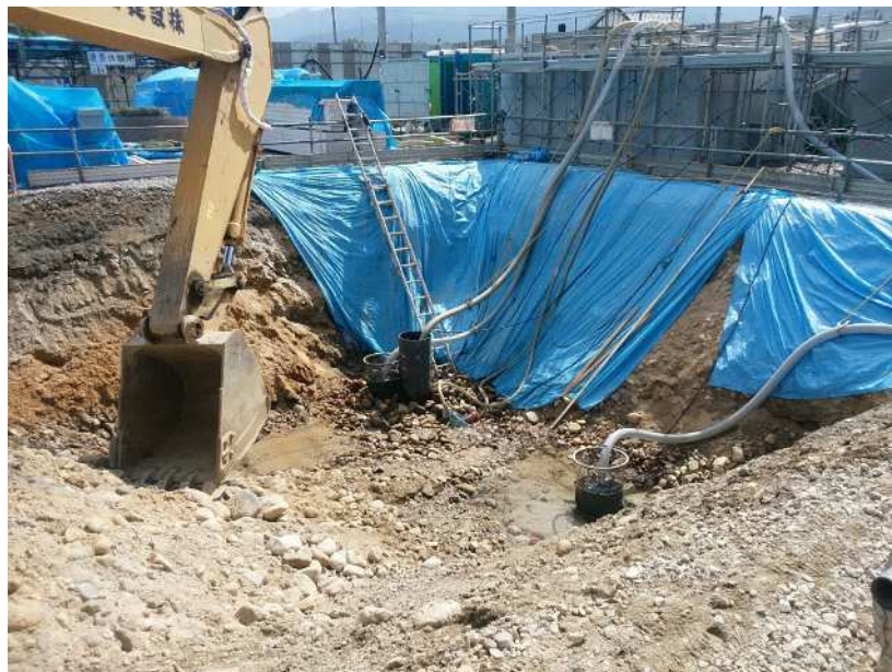
水中ポンプ セット状況
