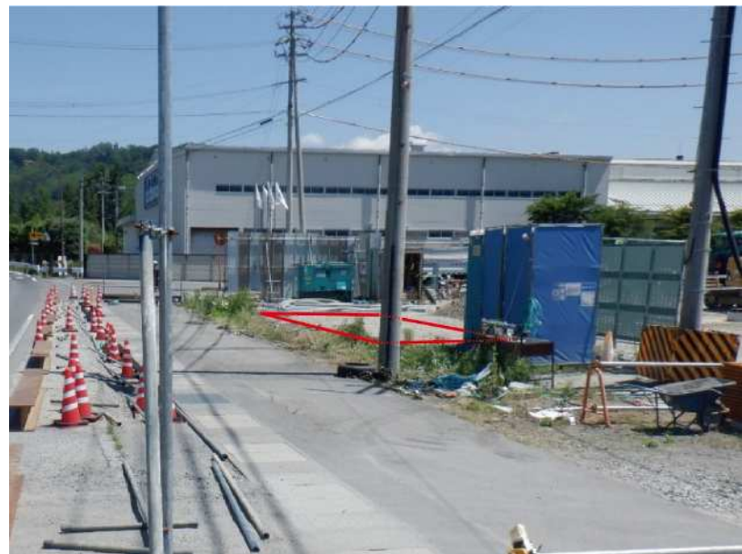
仮設処理水槽撤去後（赤線表示箇所）
