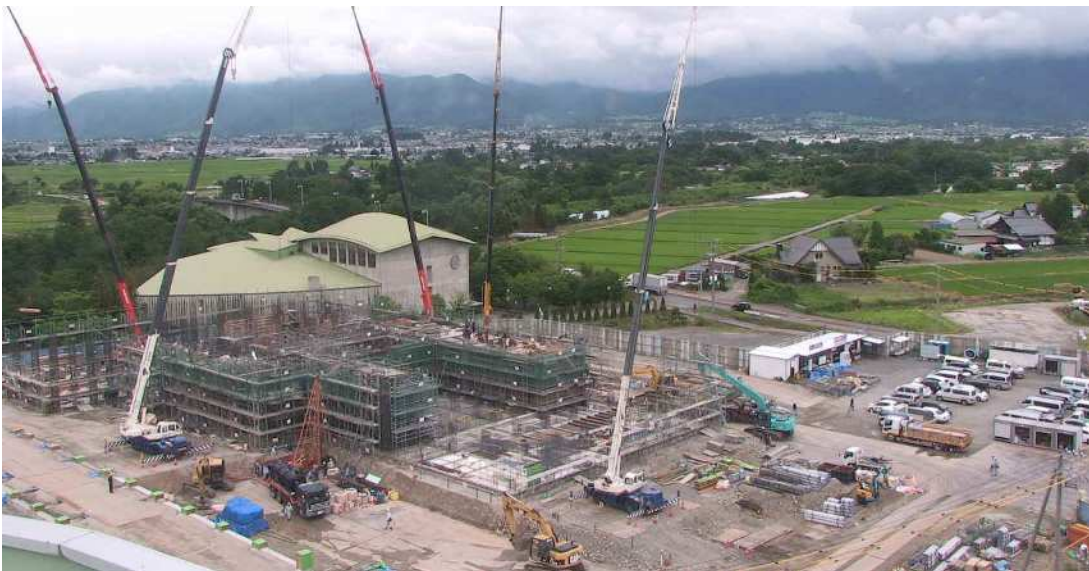
写真 7-2-1 工事状況 (令和元年 7 月)
