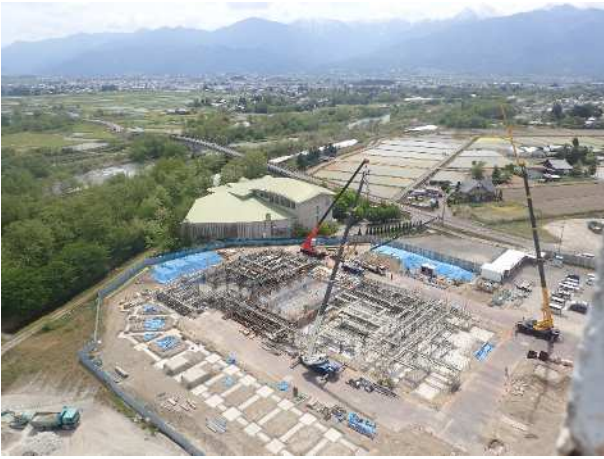
対象事業実施区域の工事の状況（5月18日）
