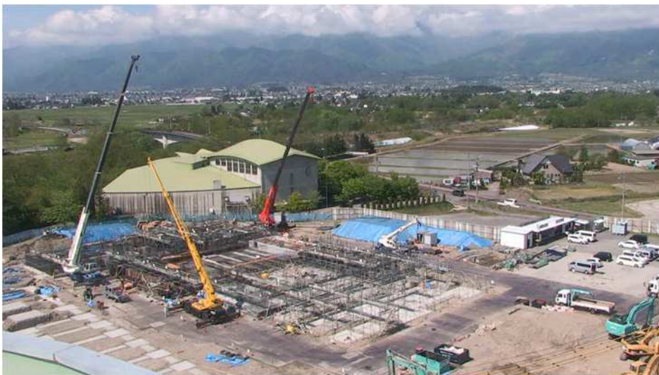
写真 7-4-1 工事状況 (令和元年 5 月)
