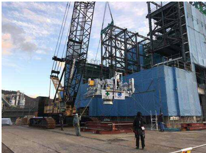
プラント工事 タービン据付状況
