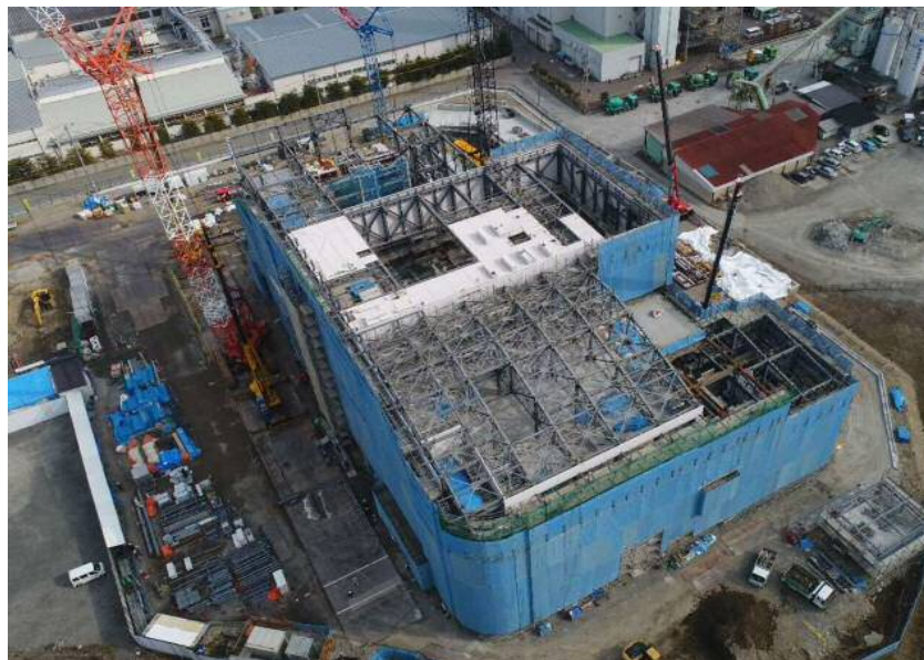
工場棟 建築工事
