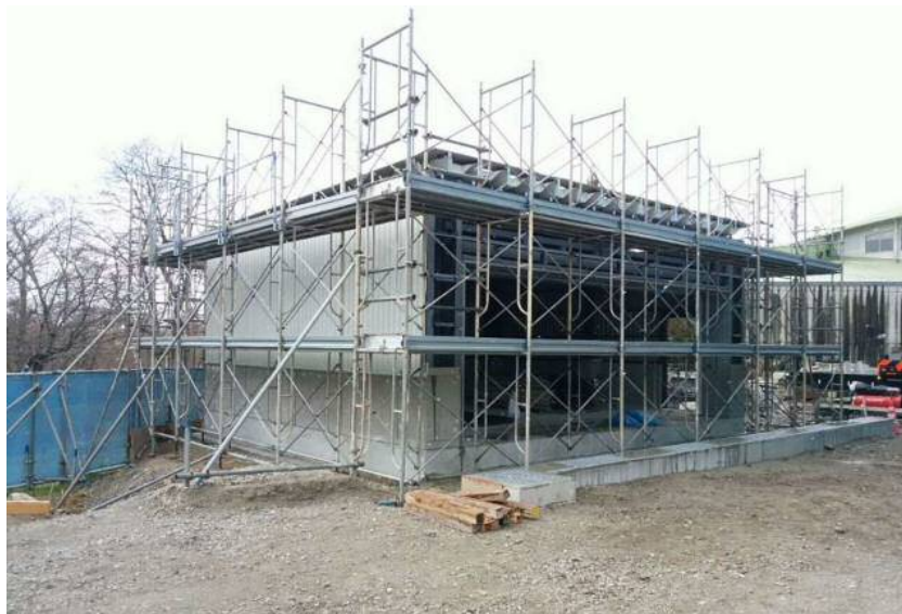
付属棟 建築工事
