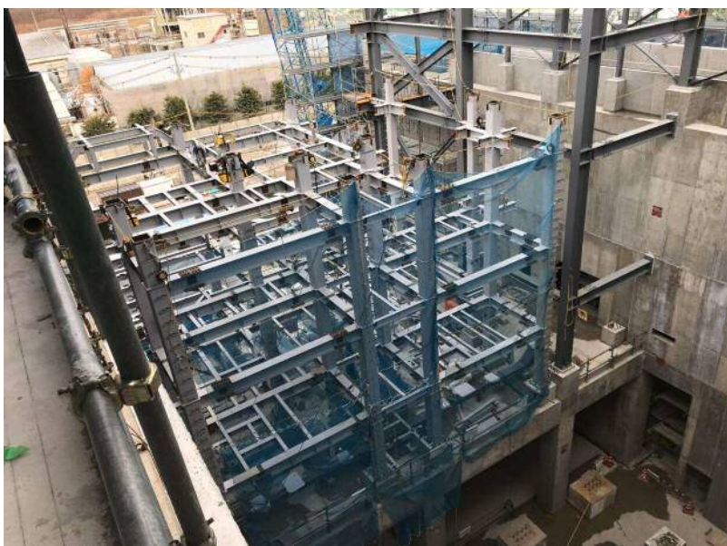
プラント工事 排ガス鉄骨建て方状況
