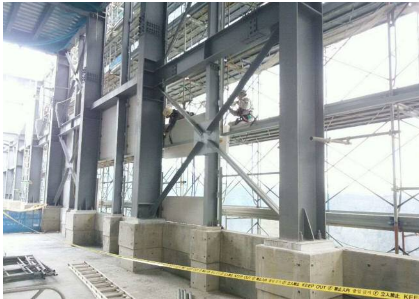
工場棟 建築工事
