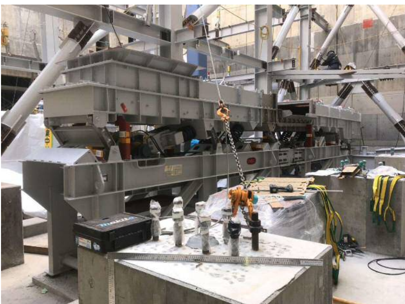
炉室 焼却灰振動コンベヤ据付状況
