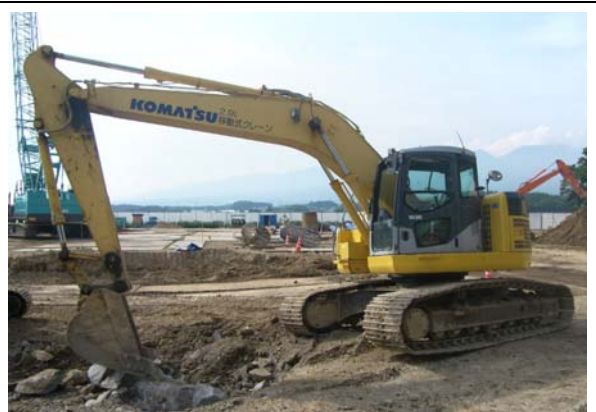
写真 4.1.4 低騒音型建設機械の使用
