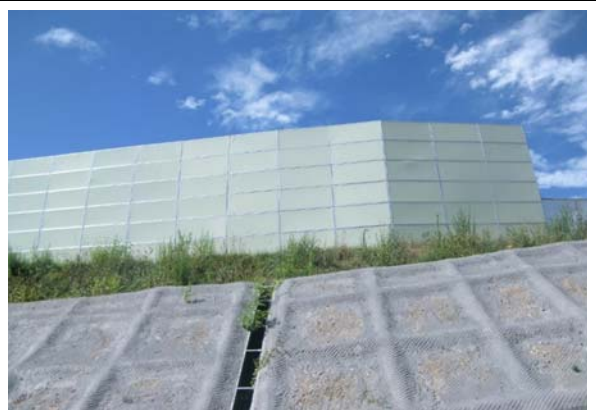
写真 4.1.6 遮音壁の設置状況
