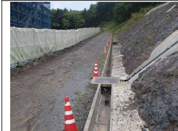
写真 3.2.1 工事区域外からの流入抑制
