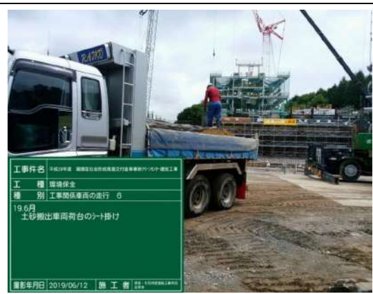
写真 3.1.7 土砂搬出車両荷台のシート掛け
