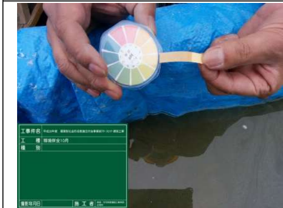
写真 3.2.3 水素イオン濃度監視の状況
