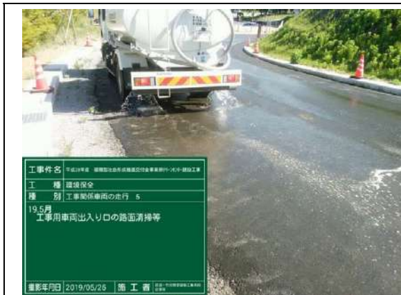
写真 3.1.6 構内道路の路面洗浄
