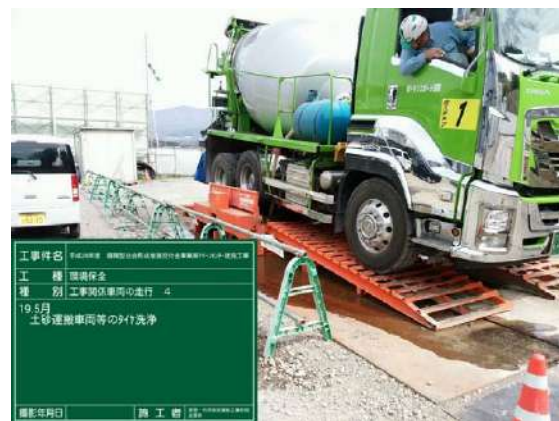
写真 3.1.5 工事関係車両のタイヤ洗浄
