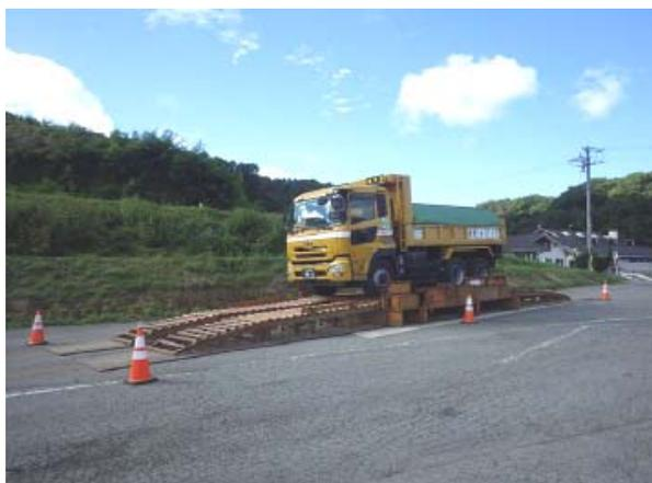
写真 4-1-7 泥落装置の設置
