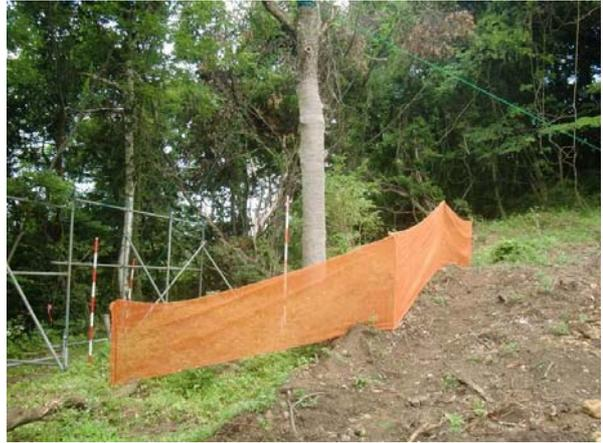
写真 4-5-8 移植木保護のための仮囲い作業
