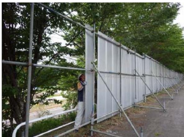
写真 4-1-12 工事用仮囲いの設置
