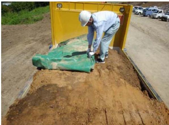
写真 4-1-9 ダンプ荷台のシートの敷設
