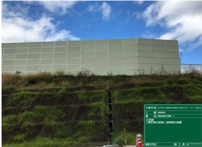
写真19 建設機械の稼働 No.4 工事区域の仮囲い ・遮音壁の設置 撮影日 2018/10/6
