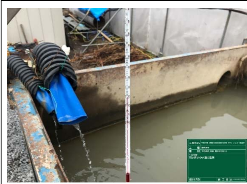
写真28 土地造成、掘削、樹木の伐採 No.9 雨水排水の水溫の監視 11℃ 撮影日 2018/10/24
