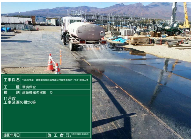
写真21 建設機械の稼働 No.5 工事区域への散水等 撮影日 2018/11/14
