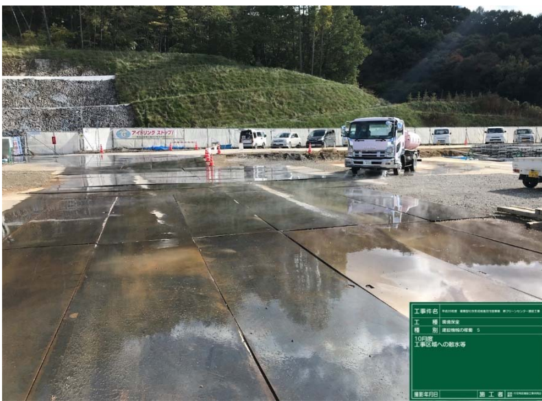
写真20 建設機械の稼働 No.5 工事区域への散水等 撮影日 2018/10/24
