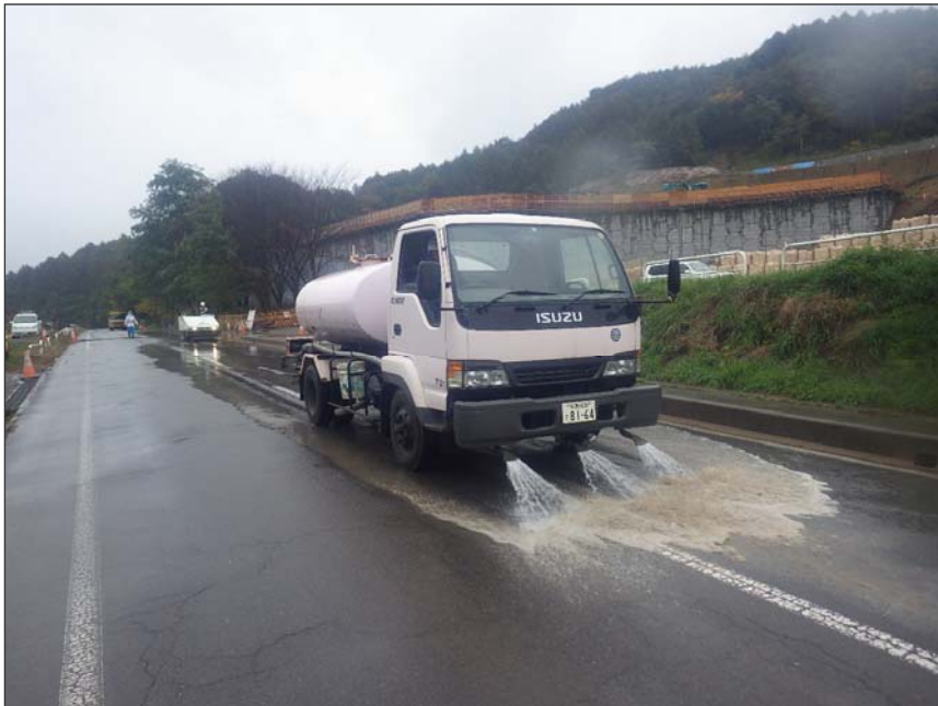
写真区分:環境対策 工種:環境コンサル(6) 種別:工事用車両出入口の路面洗淨 写真タイトル:路面散水状況 撮影箇所:現場出入口道路
