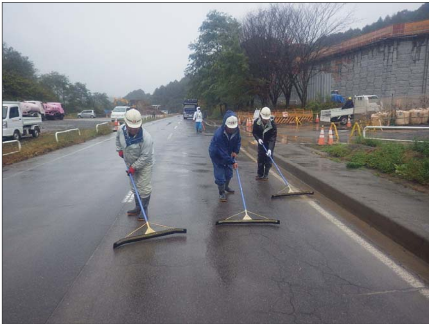
写真区分:環境対策 工種:環境コンサル(6) 種別:工事用車両出入口の路面洗淨 写真タイトル:人力清掃状況 撮影箇所:現場出入口道路
