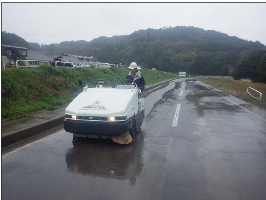
写真区分:環境対策 工種:環境コンサル(6) 種別:工事用車両出入口の路面洗淨 写真タイトル:機械清掃状況 撮影箇所:現場出入口道路
