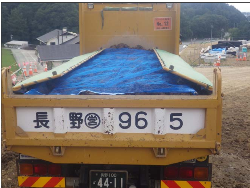
写真区分:環境対策 工種:環境コンサル(5) 種別:土砂運搬車両飛散防止 写真タイトル:荷台シート養生 撮影箇所:現場にて
