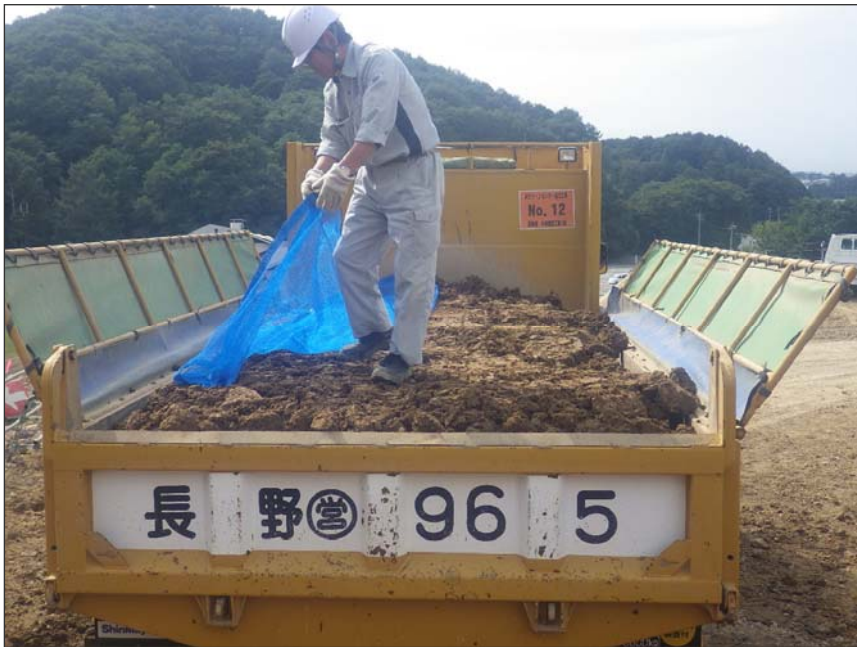
写真区分:環境対策 工種:環境コンサル(5) 種別:土砂運搬車両飛散防止 写真タイトル:荷台シート養生 撮影箇所:現場にて
