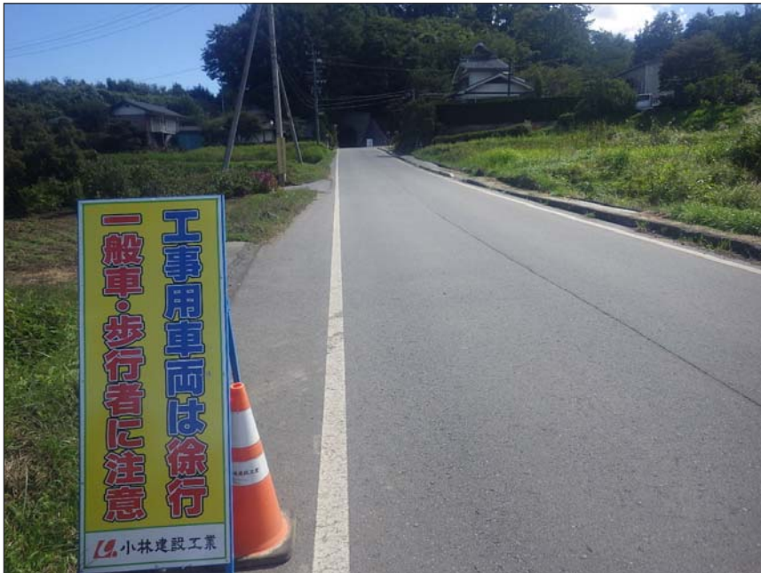
写真区分:環境対策 工種:環境コンサル(5) 種別:交通規制の遵守 写真タイトル:看板設置状況 撮影箇所:御代田町豊昇残土 運搬経路
