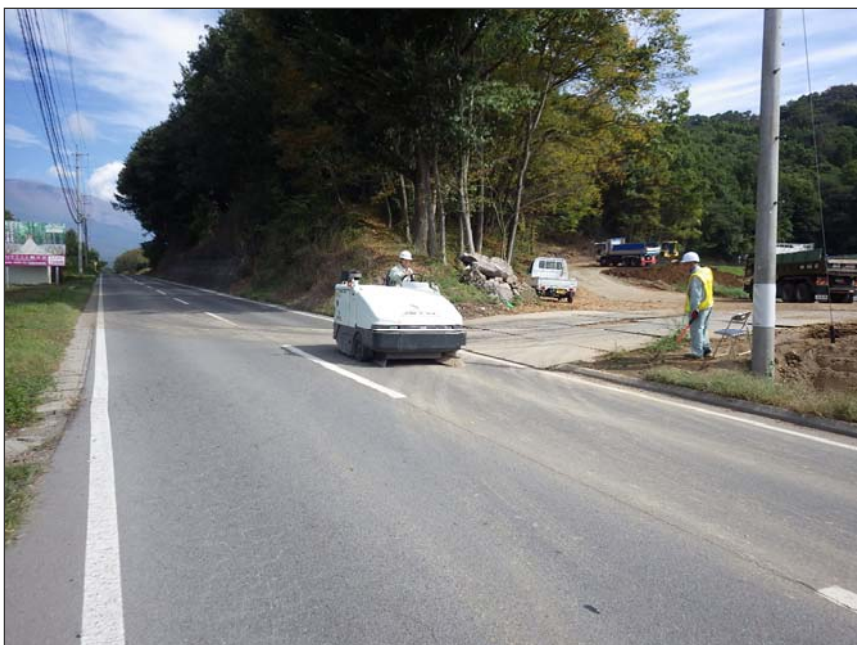
写真区分:環境対策 工種:環境コンサル(5) 種別:工事車両出入口の路面 洗浄 写真タイトル:路面清掃車使 用状況 撮影箇所:平尾造成地残土運 搬経路
