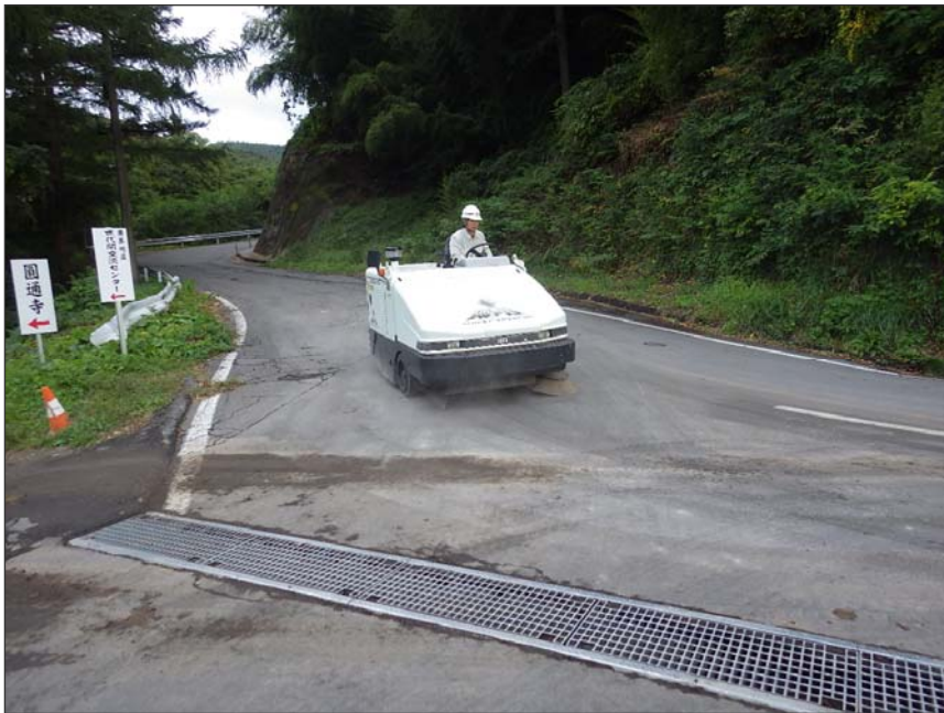
写真区分:環境対策 工種:環境コンサル(5) 種別:工事車両出入口の路面 洗浄 写真タイトル:路面清掃車使 用状況 撮影箇所:御代田町豊昇残土 運搬経路
