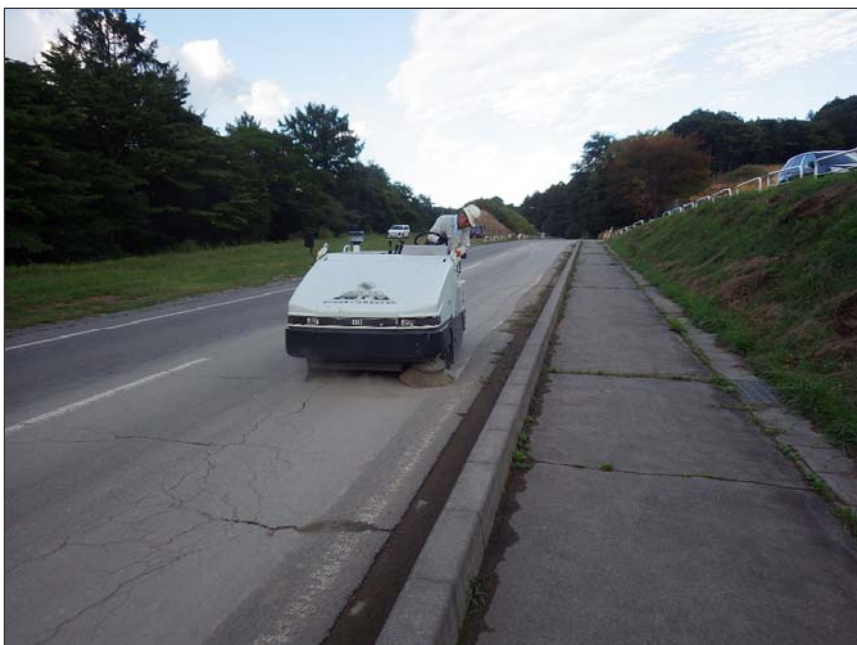
写真区分:環境対策 工種:環境コンサル(5) 種別:工事車両出入口の路面 洗浄 写真タイトル:路面清掃車使 用状況 撮影箇所:現場出入口道路
