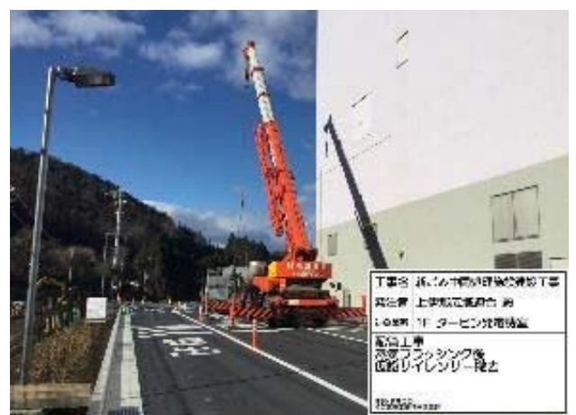
■仮設サイレンサ撤去状況
