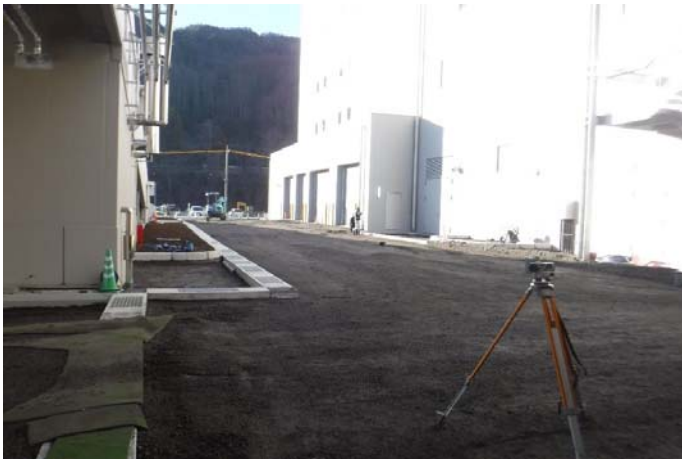
■外構路盤工事状況
