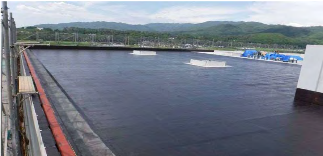
■屋上 シート防水状況
