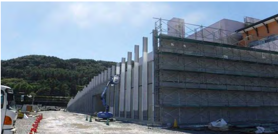
■RW工区 化粧鋼材設置・塗装状況
