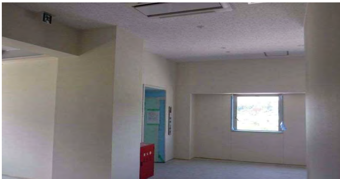
■3階見学者通路（EVホール） 内装クロス仕上げ状況
