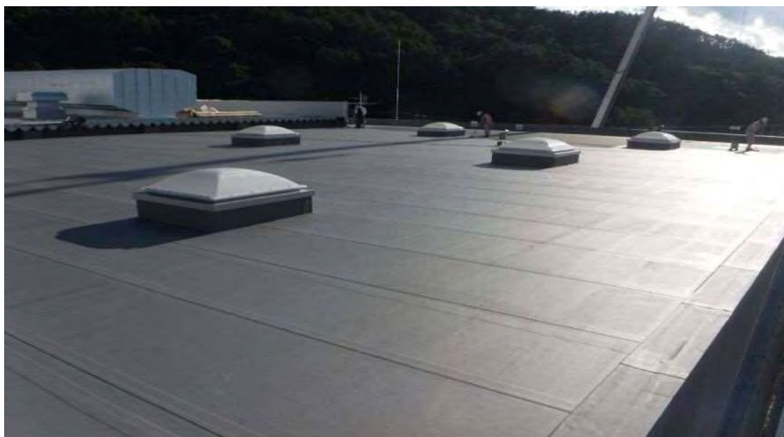
■ごみピット屋根 シート防水施工完了
