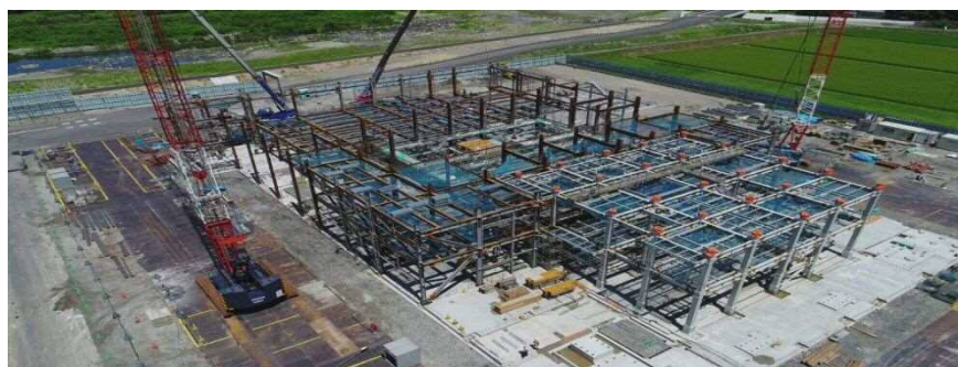
■鉄骨建て方状況
