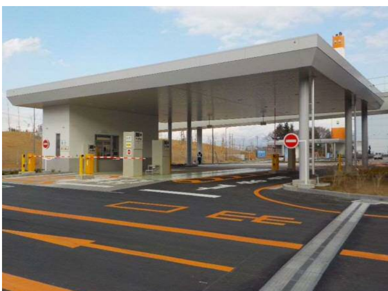
計量棟②(出口)
