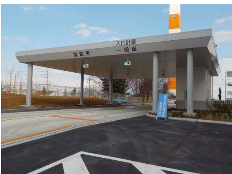
計量棟①(入口)
