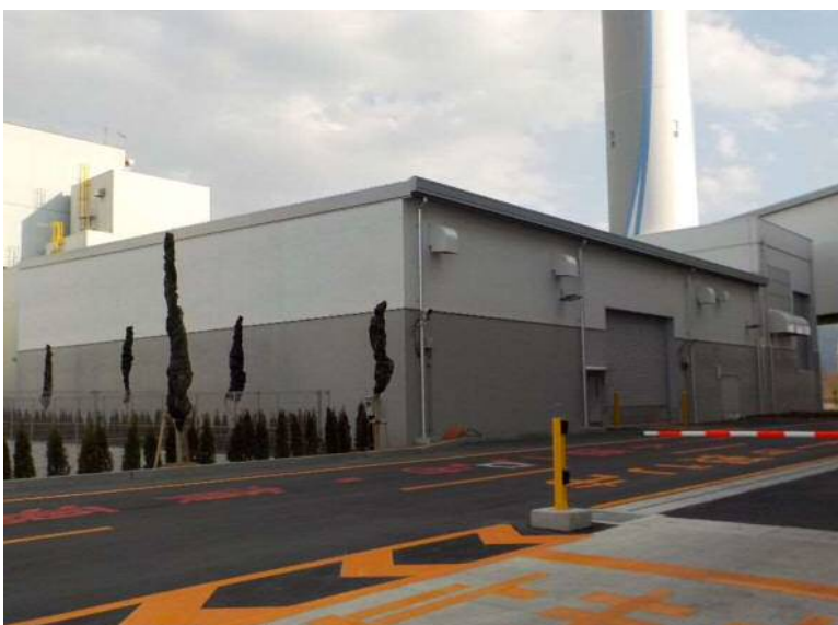
スラグストックヤード棟
