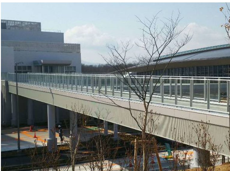
アプローチデッキ
