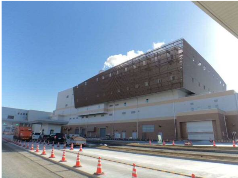
(工場棟:北側外観)
