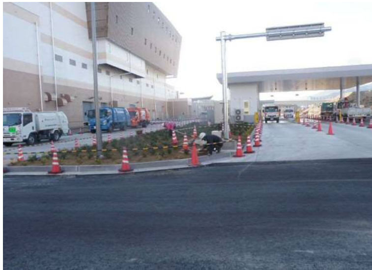
外構工事(植栽)
