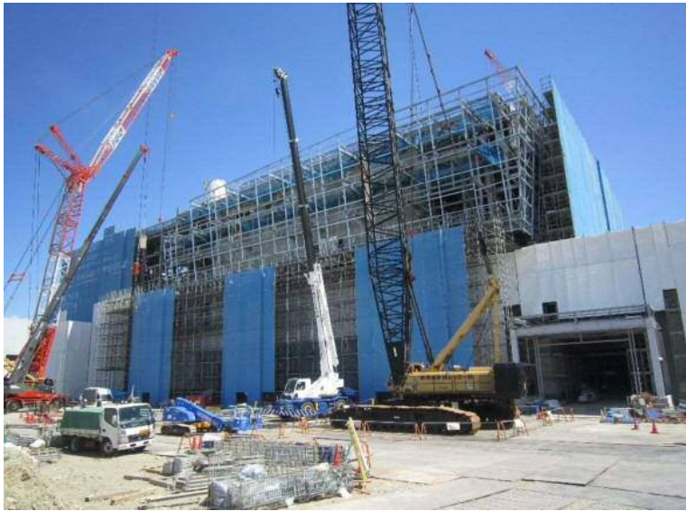
建築工事(工場棟)
