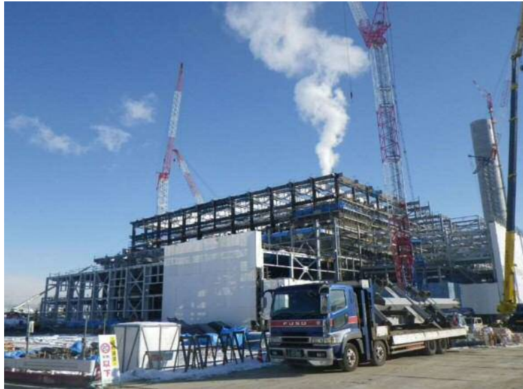
建築工事(工場棟)
