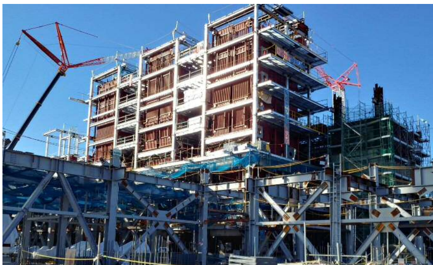
プラント工事(機器取込)
