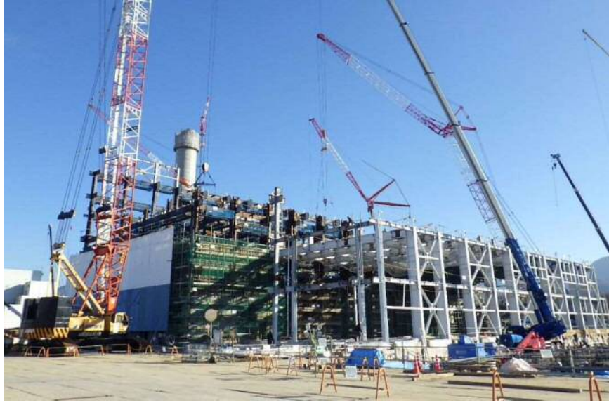
建築工事(鉄骨)
