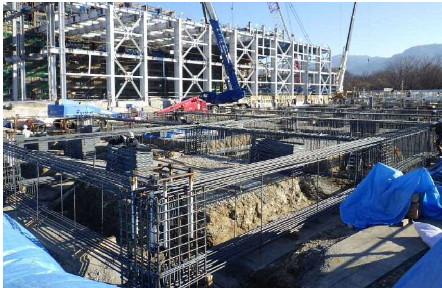
管理棟等工事(基礎)
