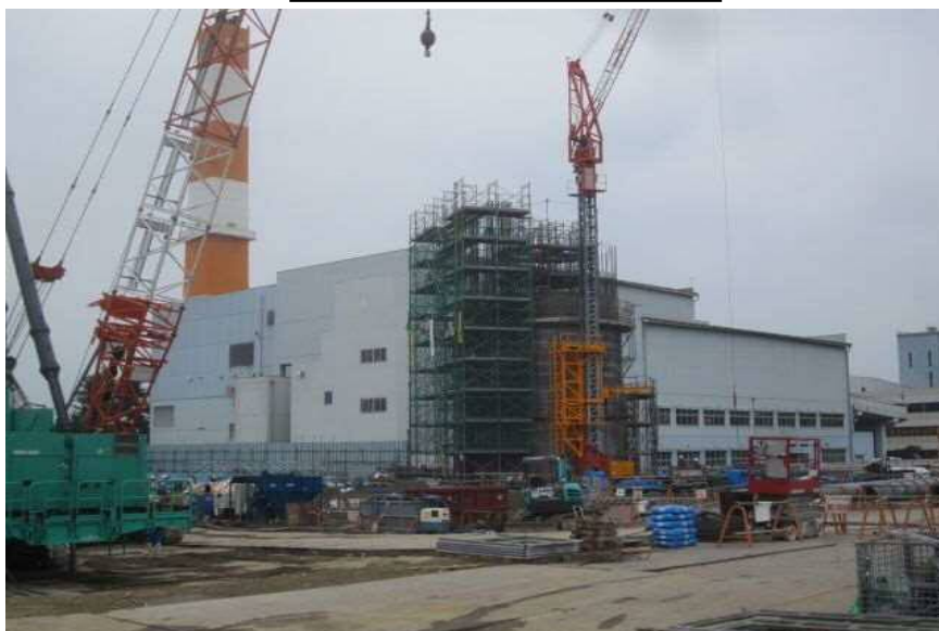
煙突(型枠・鉄筋工事)
