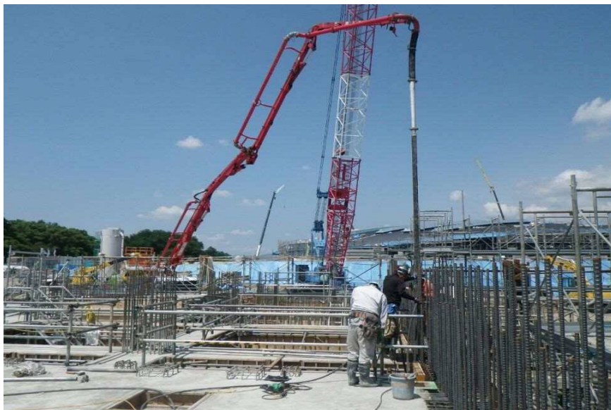
工場棟(コンクリート工事)
