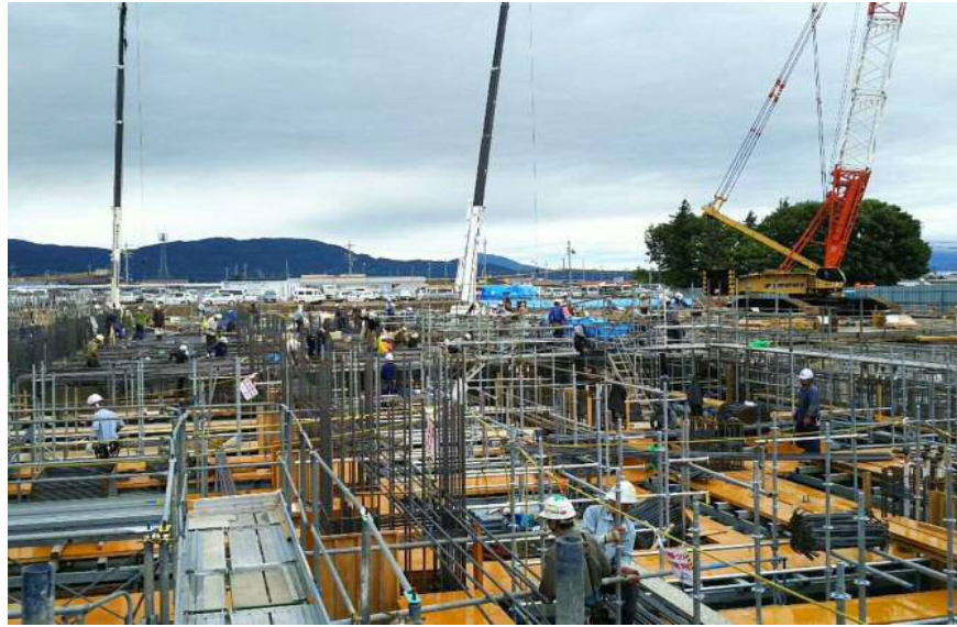
工場棟(型枠・鉄筋工事)
