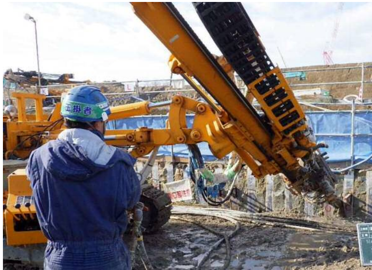
アースアンカー工事
