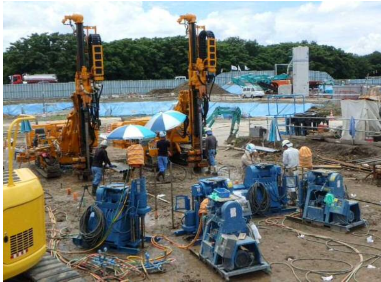
薬液注入工事
