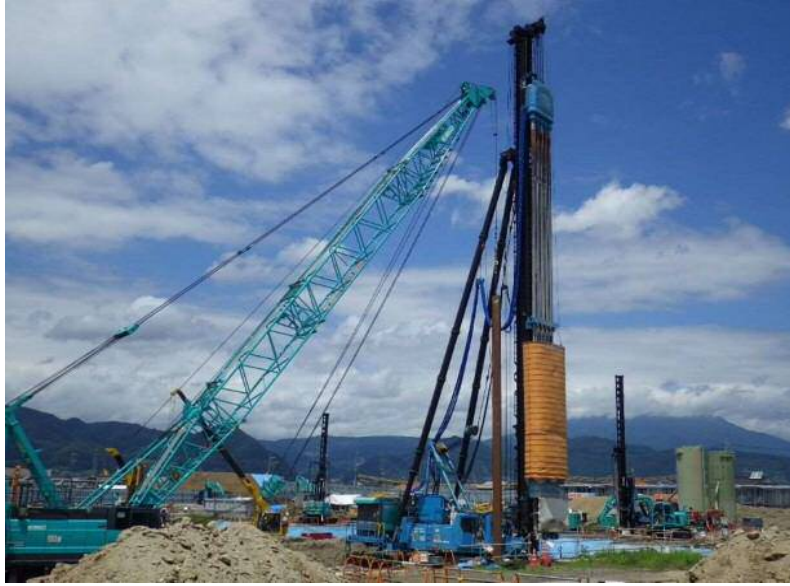
SMW(連壁)工事
