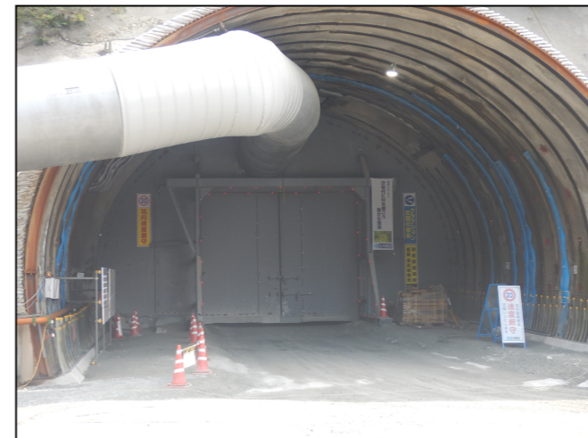
トンネル坑口 防音扉の設置
