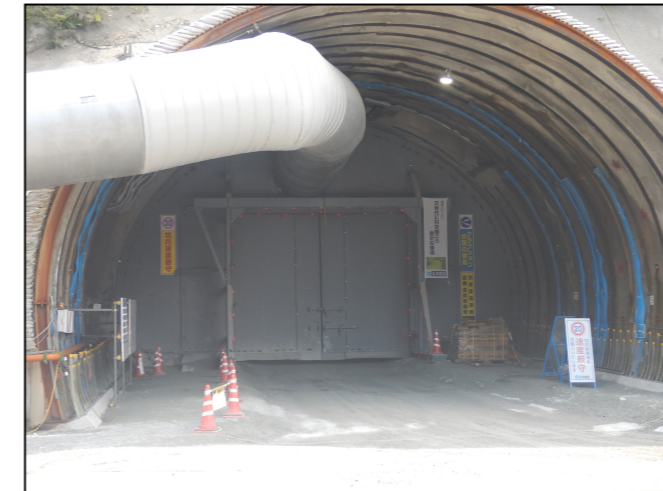
トンネル坑口 防音扉の設置
