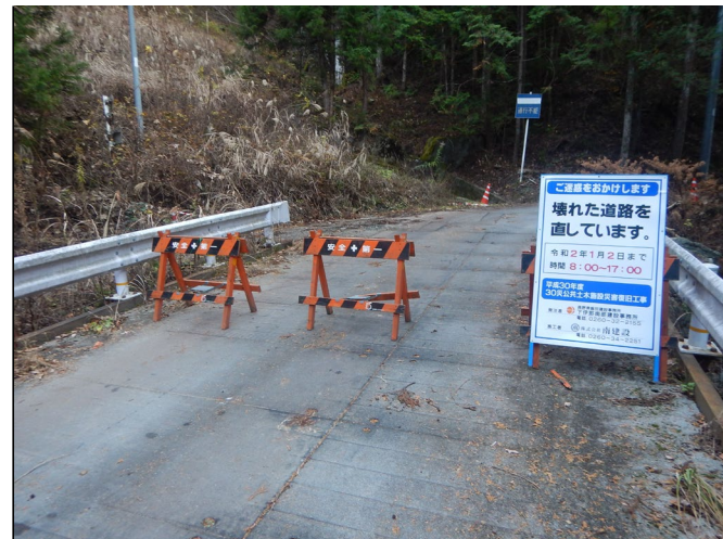
工事現場への立ち入り禁止柵
