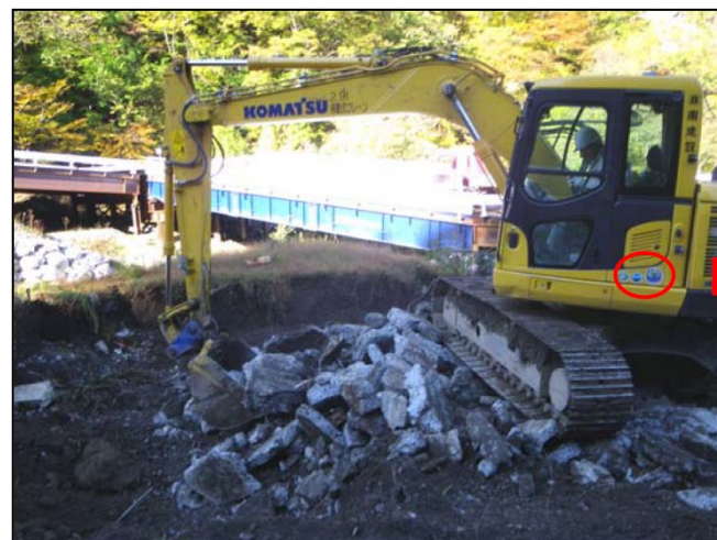
排ガス対策型・低騒音型建設機械
