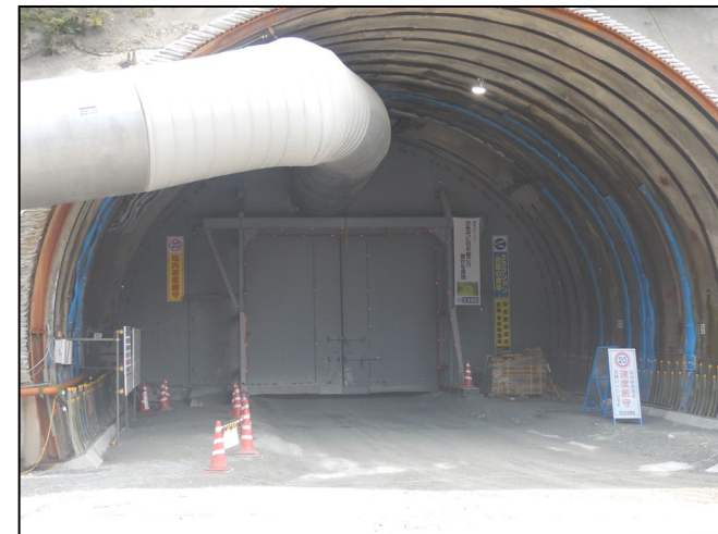
トンネル坑口 防音扉の設置
