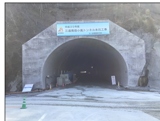
②トンネル本坑坑口
