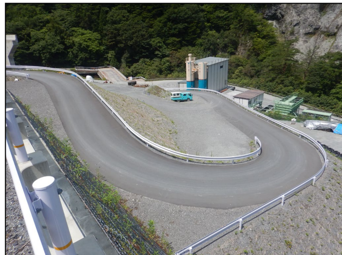
工所用道路の仮舗装
