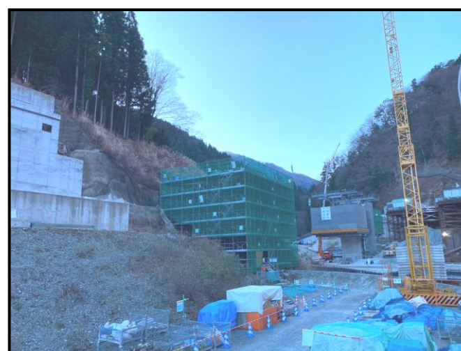
②橋梁上部工
