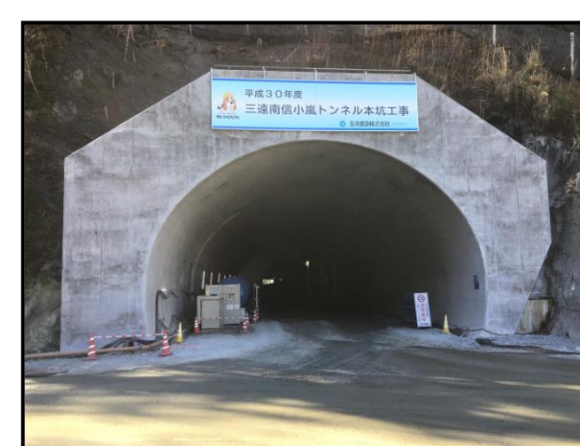
③トンネル本坑坑口
