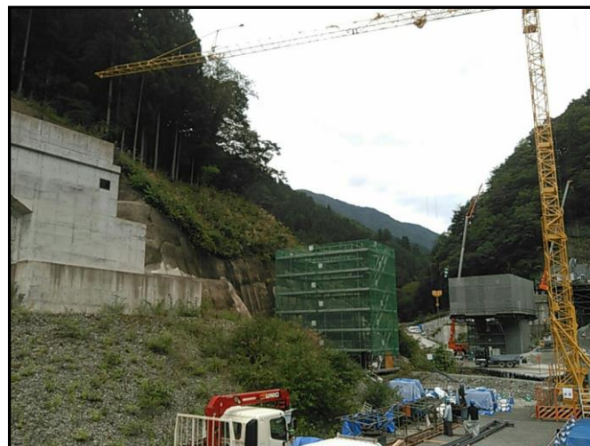
②橋梁上部工
