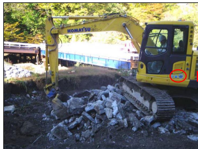
排ガス対策型・低騒音型建設機械
