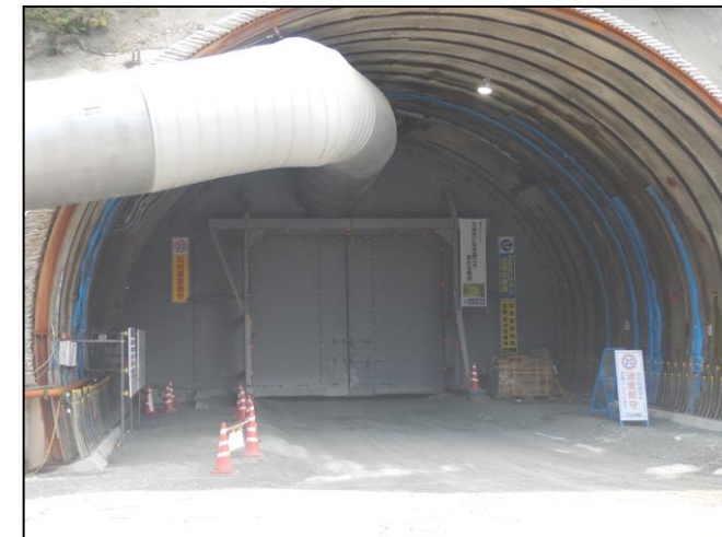
トンネル坑口 防音扉の設置
