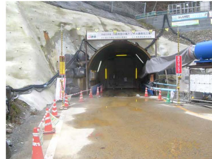
トンネル坑口
