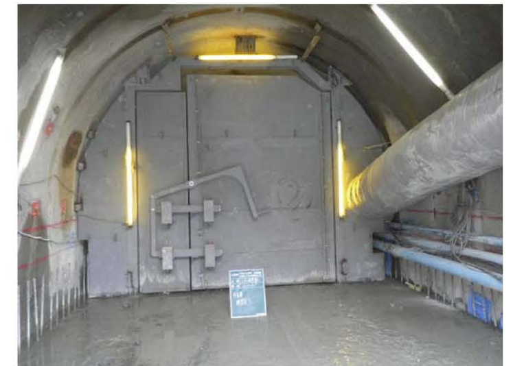
防音扉の設置
