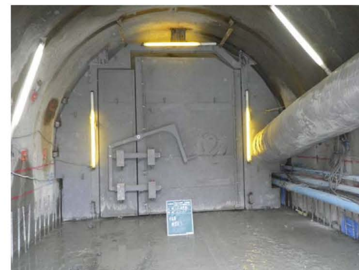
防音扉の設置
