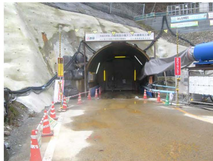
トンネル坑口
