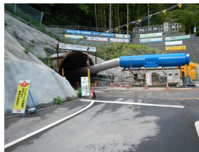
②調査坑坑口
