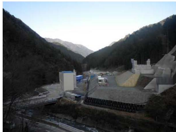
①土工-橋梁部
