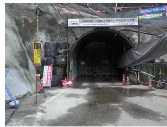
③調査坑坑口
