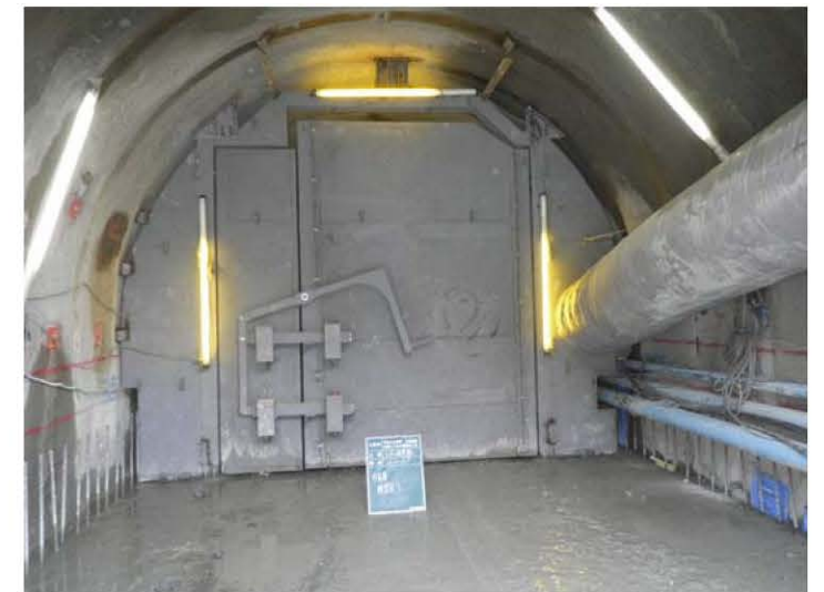
トンネル坑口 防音扉の設置
