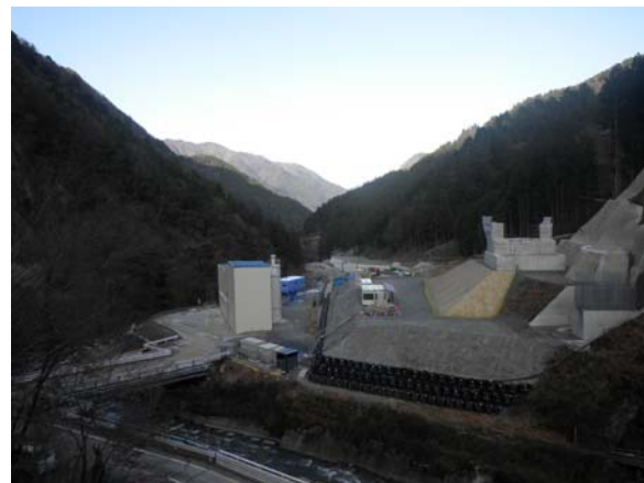
①土工-橋梁部
