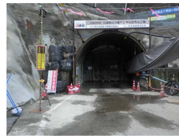
③調査坑坑口
