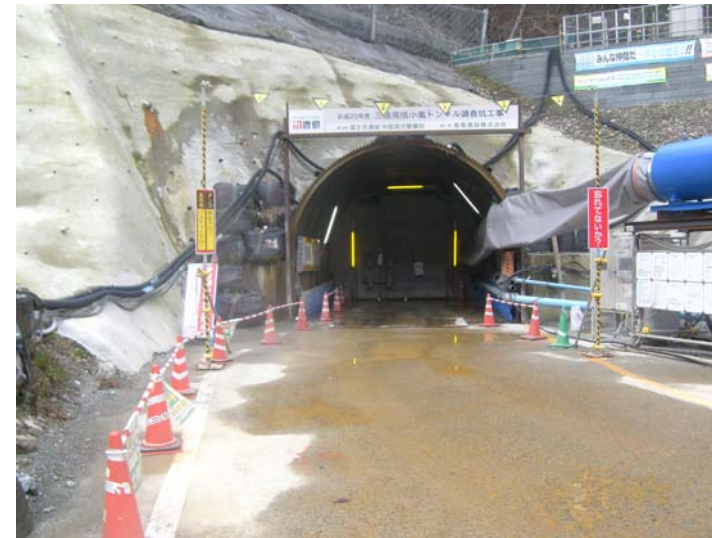
トンネル坑口 防音扉の設置
