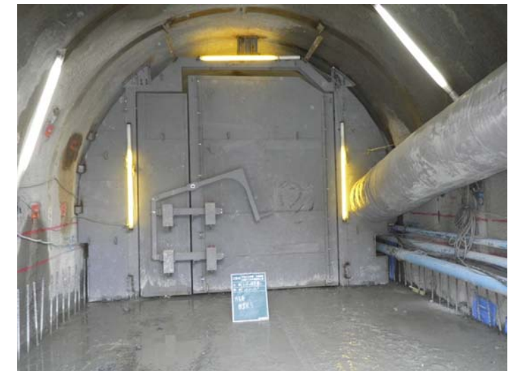
トンネル坑口 防音扉の設置
