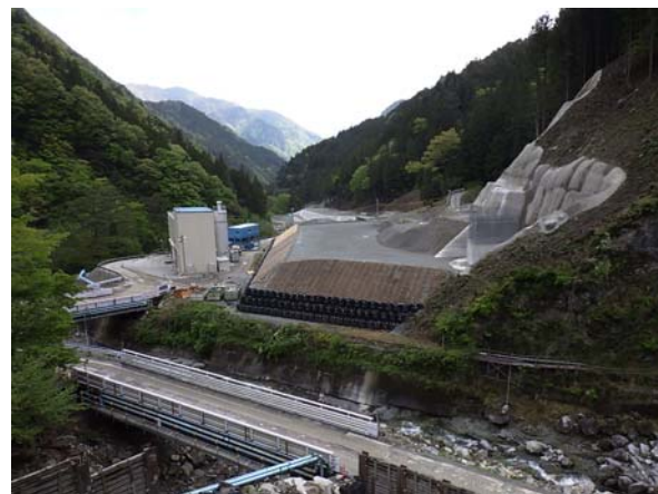
①土工-橋梁部
