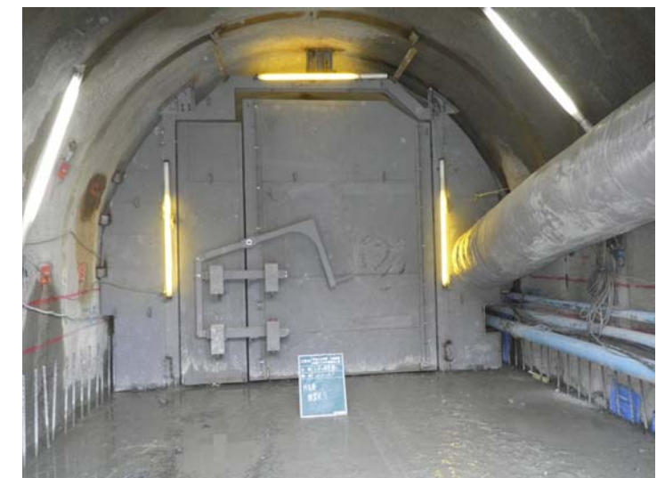
トンネル坑口 防音扉の設置
