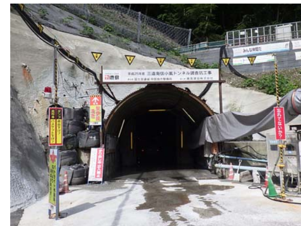
③調査坑坑口
