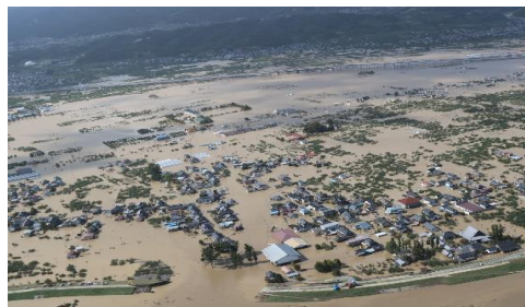
令和元年東日本台風による洪水
